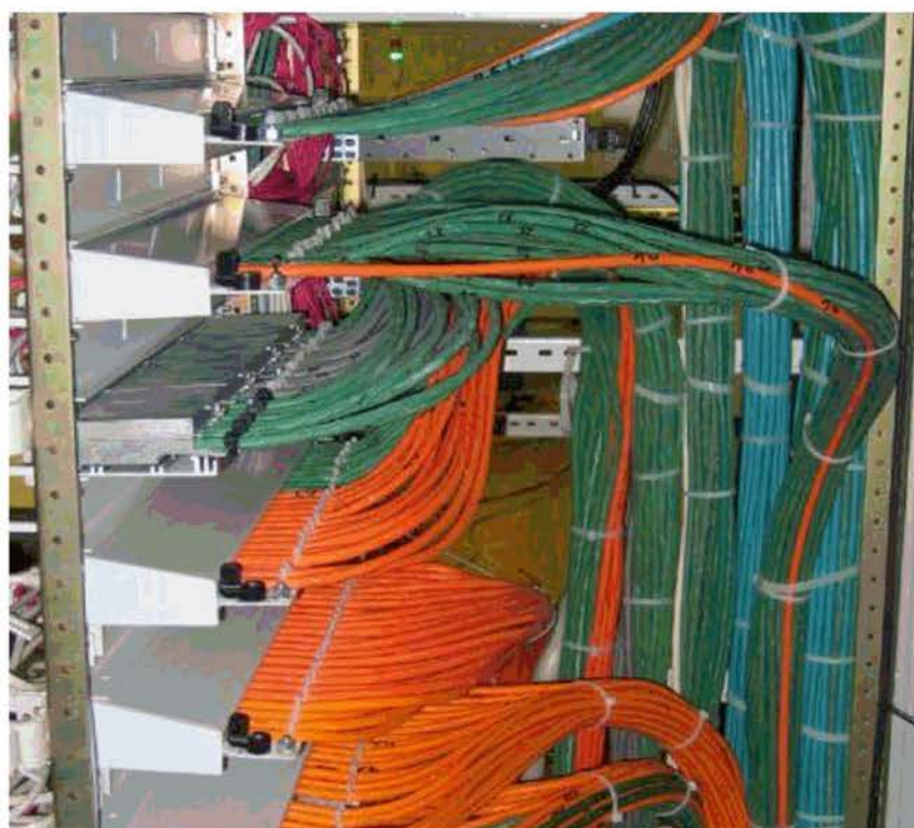
Obrázek 4.3 – Příklad kabeláže v rozvodné skříní
